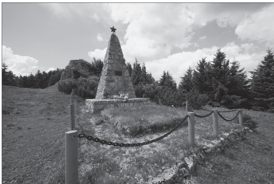
Pamätník SNP na Kráľovej studni. Múzeum SNP v Banskej Bystrici
