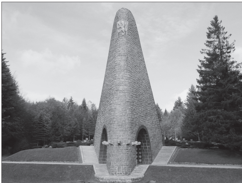
Pamätník 1. čs. armádneho zboru s vojnovým cintorínom na Dukle po obnove, 15. október 2022. VHÚ Bratislava
