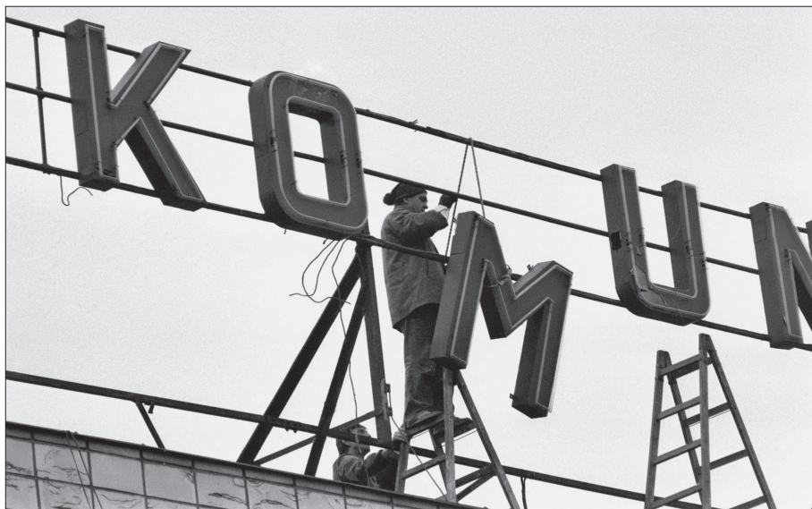
Demontáž nápisu „Sláva komunismu“ z budovy Energoprojektu v Praze, 6. 12. 1989. ČTK, foto Libor Hajský, č. 0669949414
